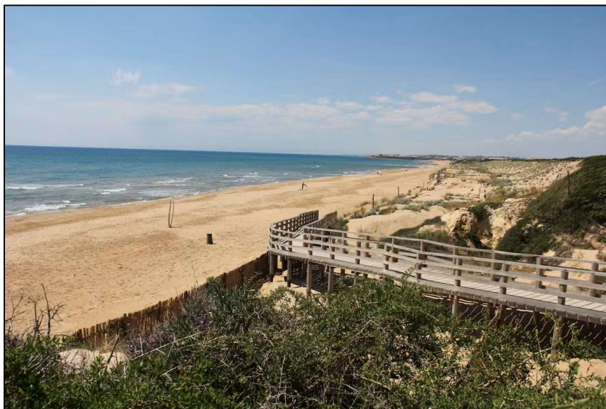
Figura 31 - Esempio di cannucciati e percorsi di accesso sopraelevati (fonte: spiaggia di Randello).
